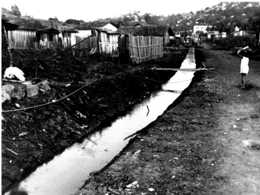
Figura 5 - Canal de lançamento de águas de esgoto, na Rua Daniel Abreu Machado
